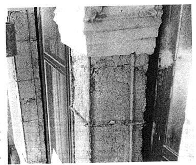
Poiché il degrado dello strato superficiale è elevato e occorre, altresì, risanare le armature presenti nel nucleo del pilastrino in c.a. si rende necessario procedere attraverso il seguente ciclo di lavorazioni:
