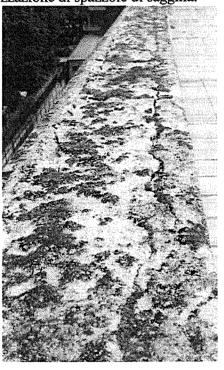
Si procederà, quindi, a rimuovere tutte quelle parti di intonaco in fase di distacco dal supporto sottostante, spesso costituito da elementi in conglomerato cementizio armato (pilastri, travi di piano, architravi, stipiti di finestre, ossatura di cornicioni o modanature delle trabeazioni).
