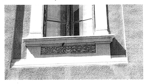
Tale ricostruzione verrà eseguita, ordinariamente, in situ con l'uso di modine, ma qualora necessario tali elementi verranno realizzarti fuori opere, mediante l'uso di matrici (in gomma siliconica o gesso) e applicati con l'utilizzazione di perni in acciaio inox e malta.
