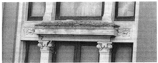
La presenza delle armature metalliche ha determinato l'espulsione di interi tratti di conglomerato cementizio corrispondente al copriferro e l'ingenerarsi di evidenti lesioni in corrispondenza delle citate armature, ormai ossidate in presenza di carbonatazione del calcestruzzo.
