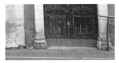
Poiché il degrado dello strato superficiale è elevato e occorre, altresì, risanare le armature presenti nel nucleo del pilastrino in c.a., si rende necessario procedere attraverso il seguente ciclo di lavorazioni:
