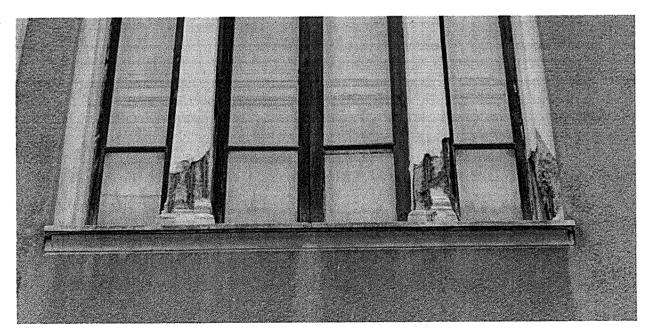
L'intonaco esterno a protezione delle colonnine è a base cementizia con finitura superficiale a tonachino costituito da cemento, polvere di marmo e graniglia di marmo.
