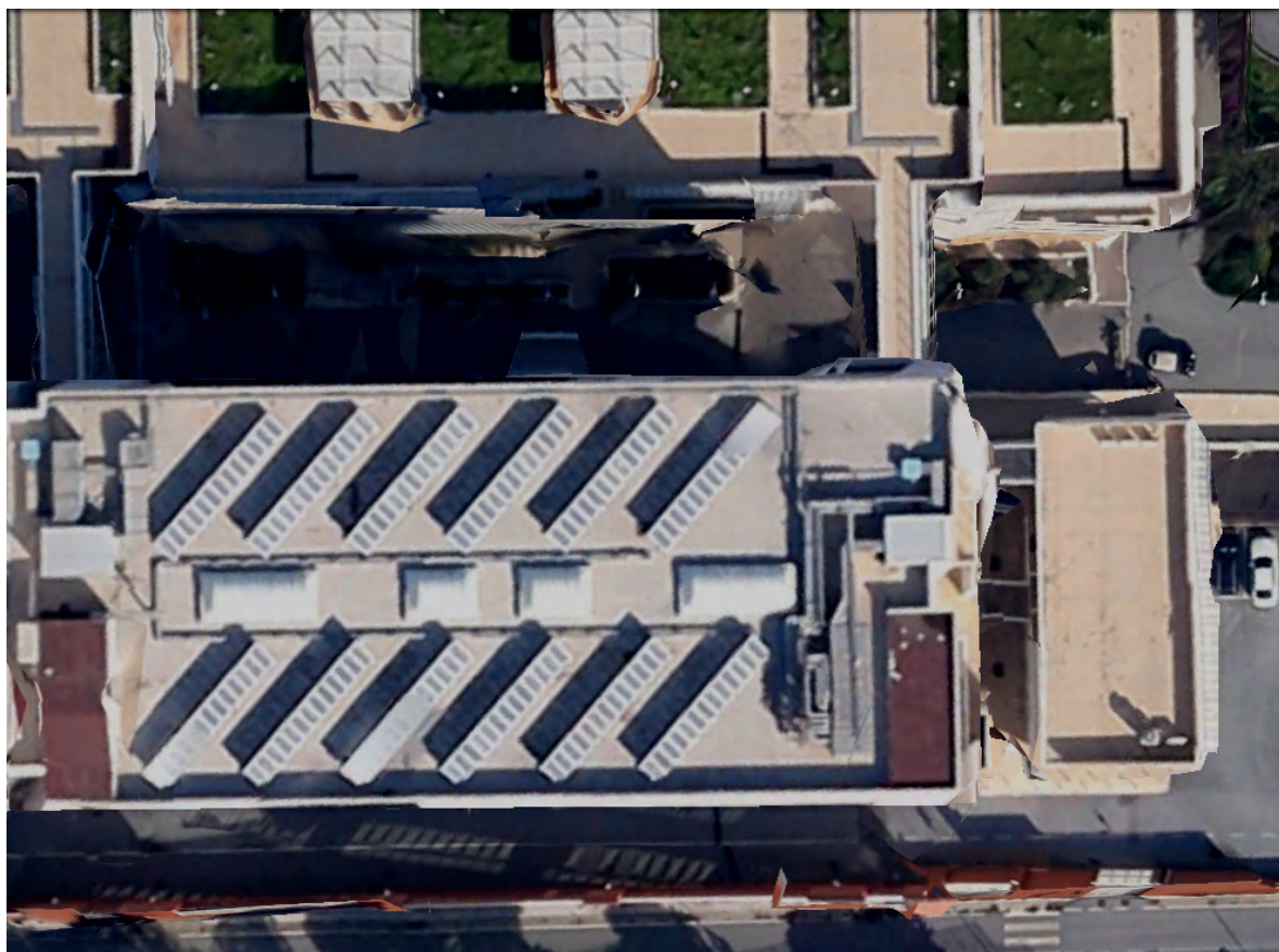
Vista dall'alto dell'impianto fotovoltaico esistente.
