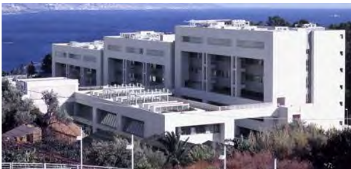
Veduta dei fabbricati Aule (in primo piano) e Uffici/Laboratori.
