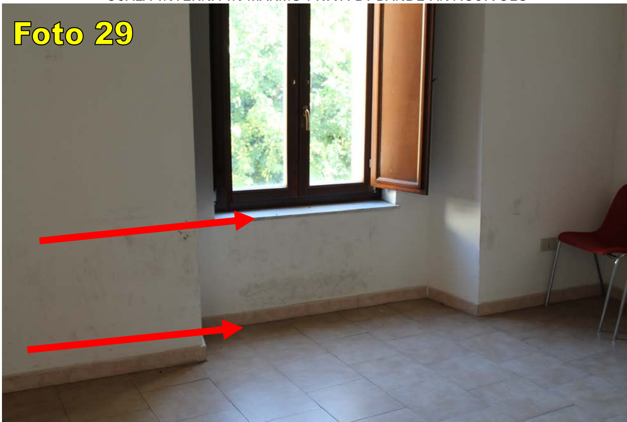
PARAPETTO FINESTRA IN MURATURA BASSO (h 65 cm)
