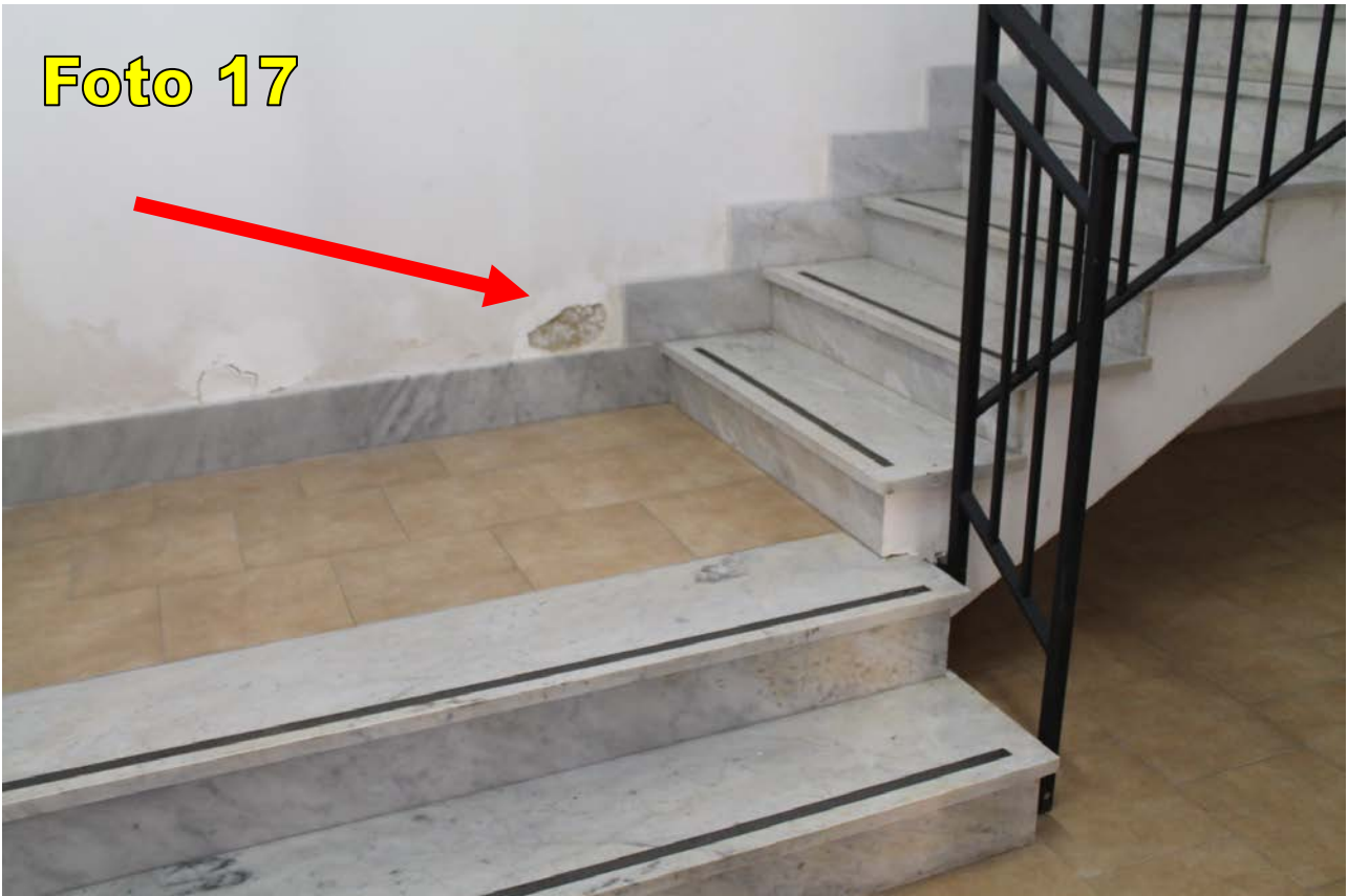
SCALA PIANO TERRAPIANO PRIMO
