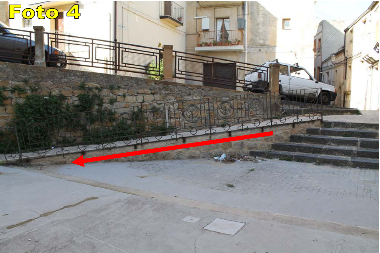
RAMPA DISABILI INGRESSO PRINCIPALE
