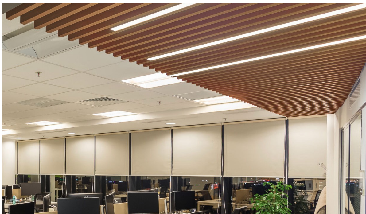
Figura 4.3 – Esempio di controsoffitto in pannelli modulari accostato a Baffle.
